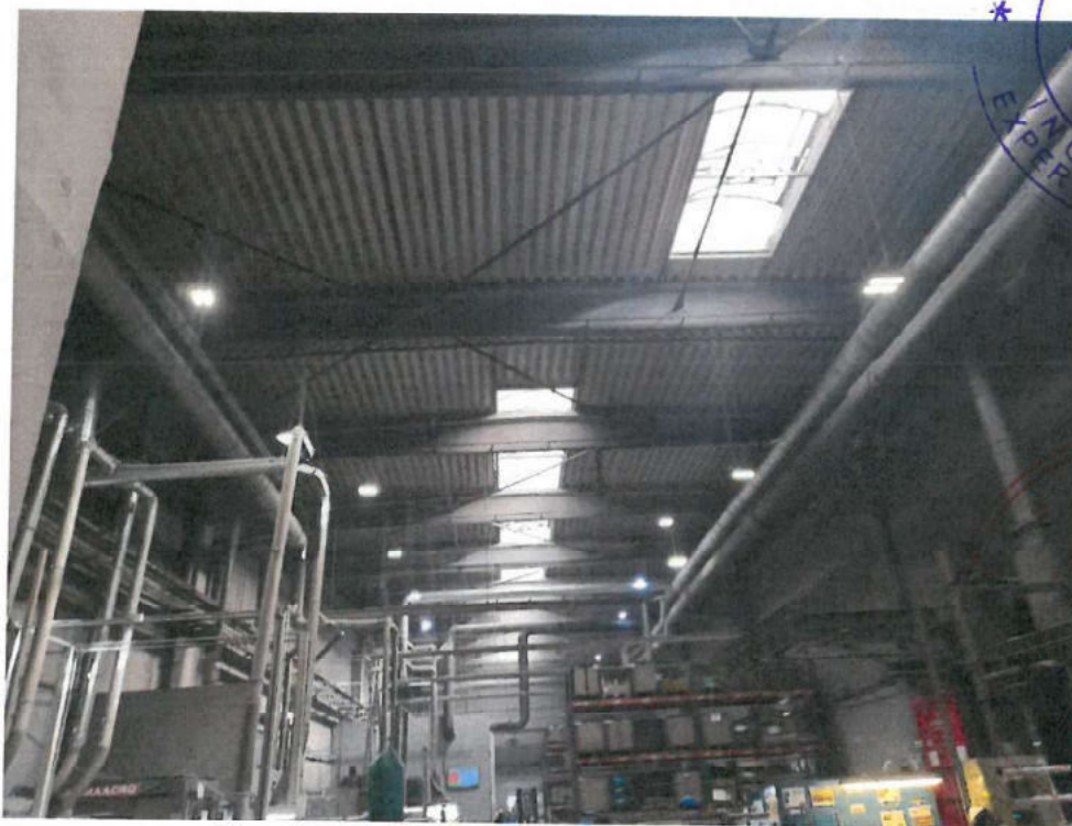
Structura acoperis – contarvânturi din tiranti
