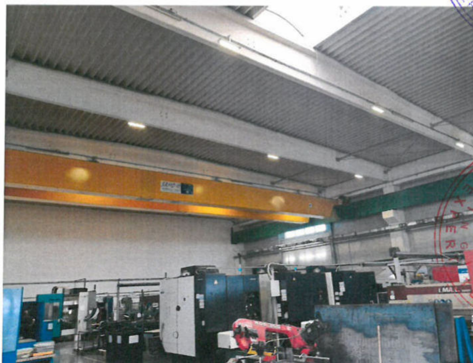
Vedere structura de rezistenta - 1
