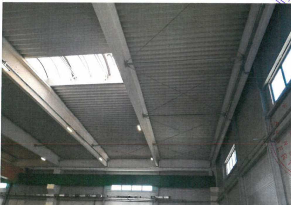
Vedere structura de rezistenta - 3
