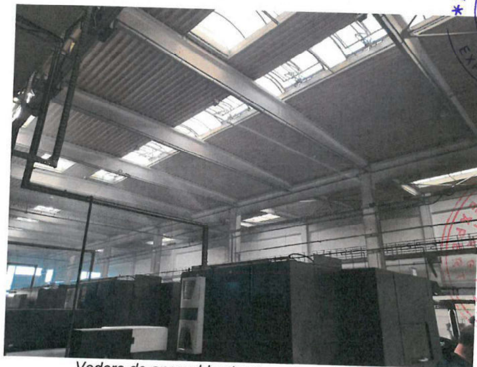
Vedere de ansamblu structura de rezistenta – 2
