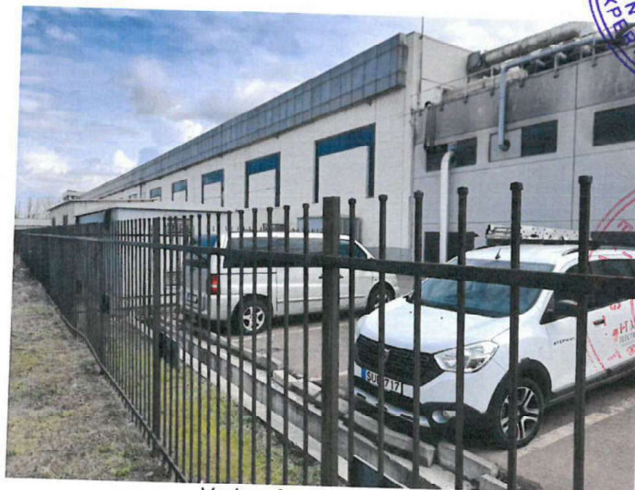
Vedere fatada secundara
