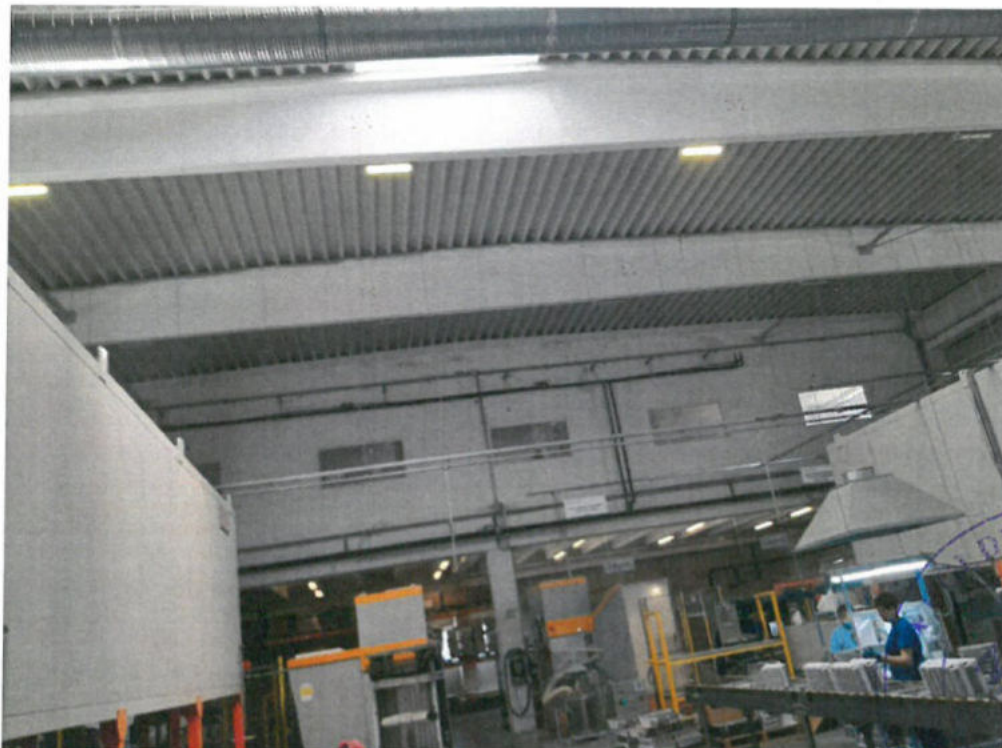
Vedere structura de rezistenta - 2
